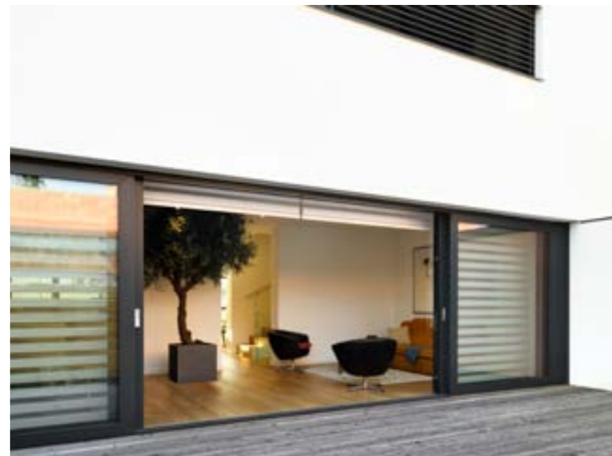
Společný obývací prostor v každém domě je širokým HS portálem propojen s terasou a pergolou. Od sousedů jsou odděleny plnými stěnami, aby bylo zajištěno více soukromí
